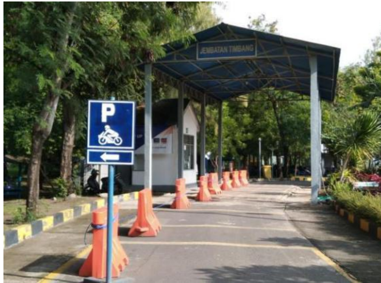
Gambar 3.5 Tidak Terdapat Portal pada Jembatan Timbang
