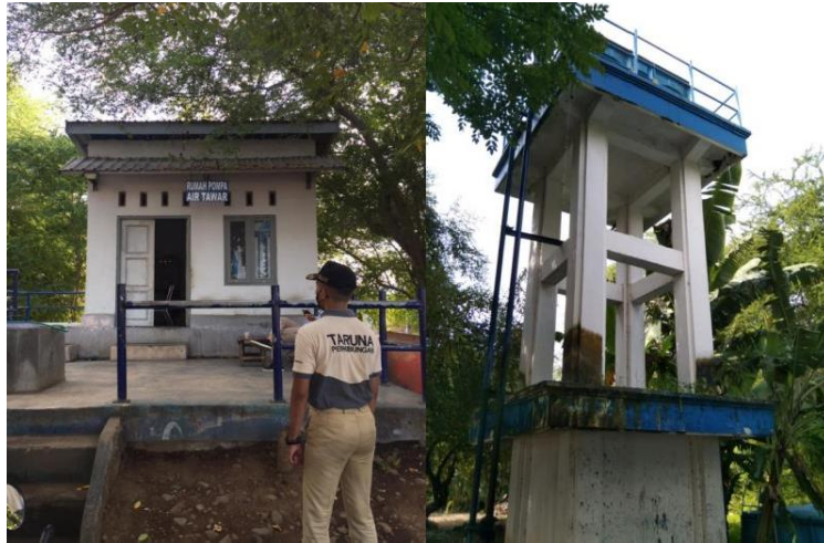
Gambar 4. 33 Ruang Pompa Air Bersih
