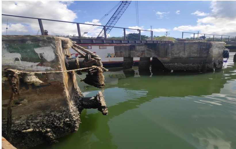
Gambar 4.5 Fender di Pelabuhan Penyeberangan Kendari
