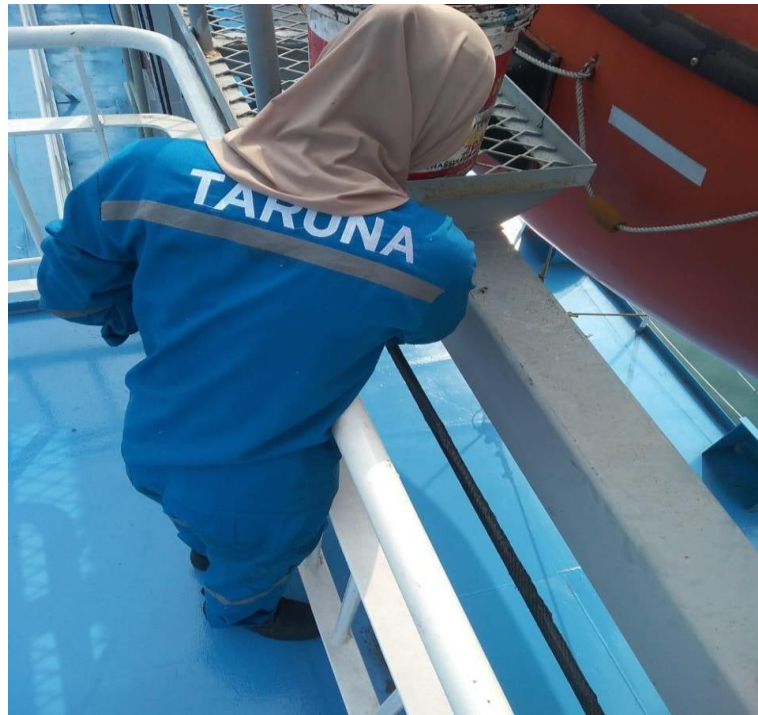
Gambar 4. 2 Pemberian Oli pada Wire Rope
