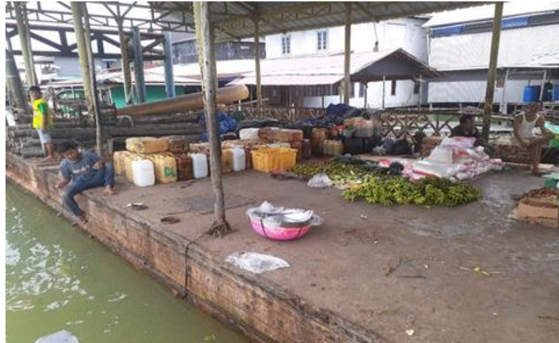
Gambar 4.10 Tidak Terdapat Fender dan Bolder di Dermaga ponton Sungai Lumpur
