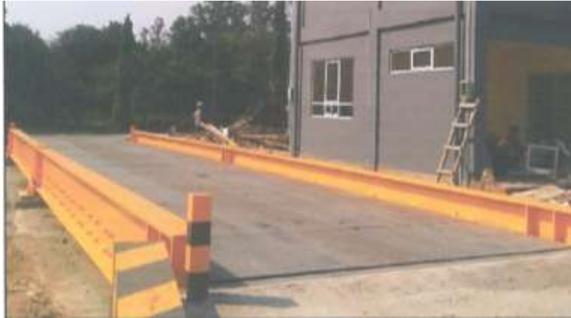
Gambar 2.1 Jembatan Timbang Permanen
