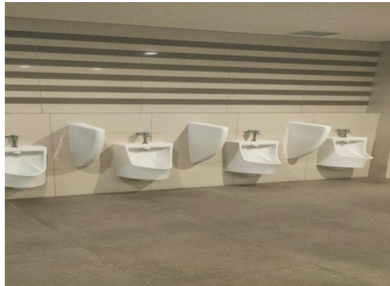
Gambar 4.9 Toilet Terminal Eksekutif di Pelabuhan Penyeberangan Bakauheni
