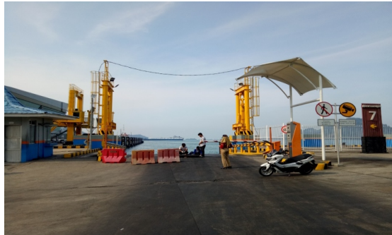
Gambar 4.13 Dermaga 2 di Pelabuhan Penyeberangan Bakauheni
