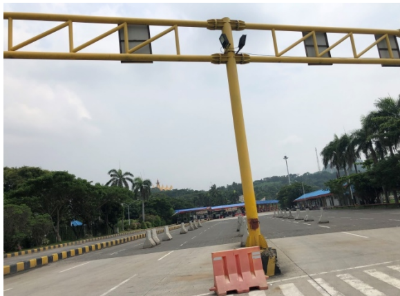
Gambar 4.5 Areal Siap Muat Pelabuhan Penyeberangan Bakauheni
