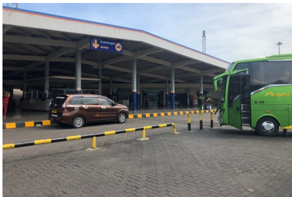
Gambar 4.3 Gedung Terminal Pelabuhan Penyeberangan Bakauheni
