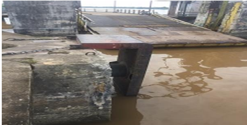
Gambar 4. 19 Fender Pelabuhan Penyeberangan Rasau Jay
