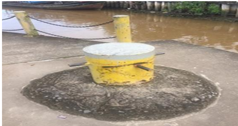
Gambar 4. 18 Bolder Pelabuhan Penyeberangan Rasau Jaya
