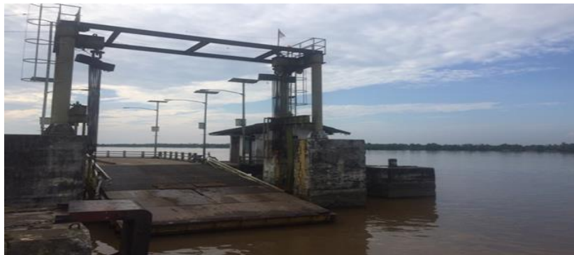
Gambar 4. 15 Movable Bridge Pelabuhan Penyeberangan Rasau Jaya
