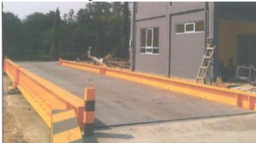
Gambar 2.1 Jembatan Timbang Permanen
