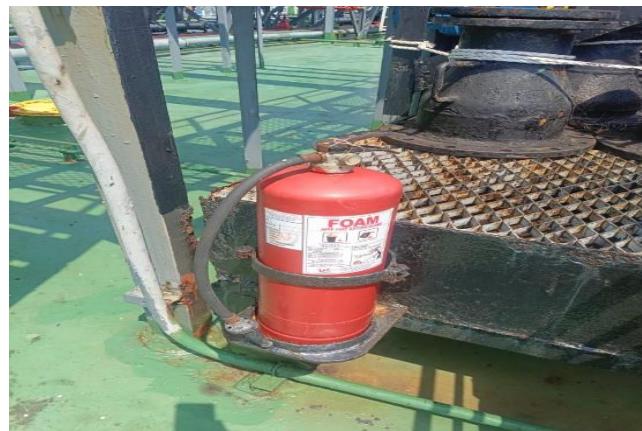
Gambar 4.2 APAR yang tidak layak digunakan
