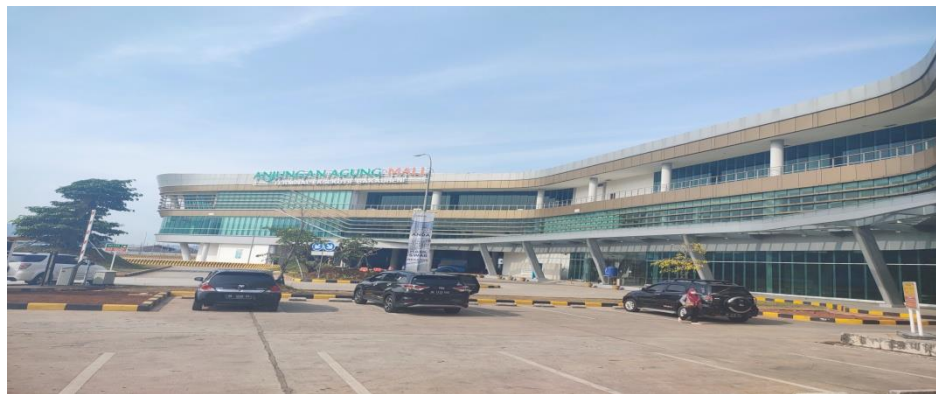
Gambar 4.3 Lapangan Parkir Terminal Eksekutif di Pelabuhan Penyeberangan Bakauheni
