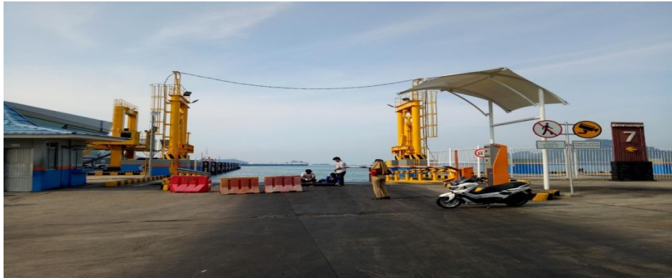
Gambar 4.2 Dermaga Moveable Bridge Terminal Eksekutif di Pelabuhan Penyeberangan Bakauheni Eksekutif
