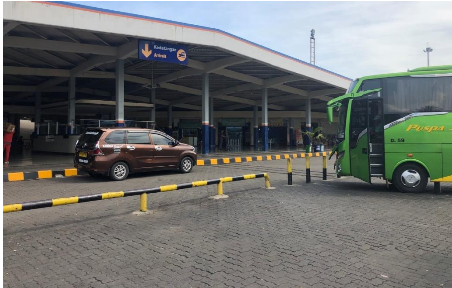
Gambar 4.10 Terminal Kedatangan di Terminal Eksekutif Pelabuhan Penyeberangan Bakauheni
