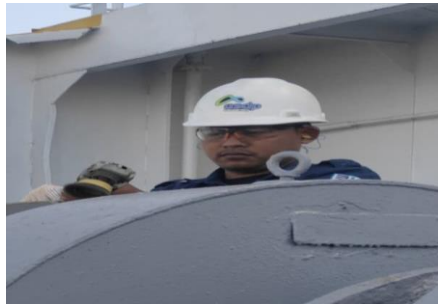
Gambar 4. 8 Brushing tanpa Menggunakan safety Mask
