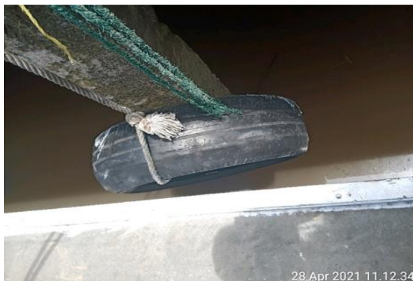
Gambar 4.11 Fender diPelabuhan Sungai Rasau Jaya
