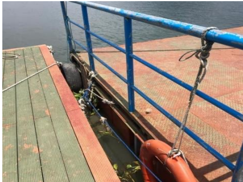
Gambar 4. 17 Kondisi Fender Dermaga Servis Jatiluhur
