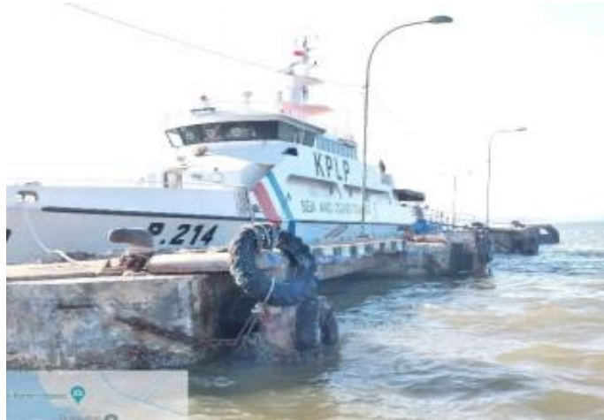
Gambar 4.17 Fender di Pelabuhan Penyeberangan Jepara
