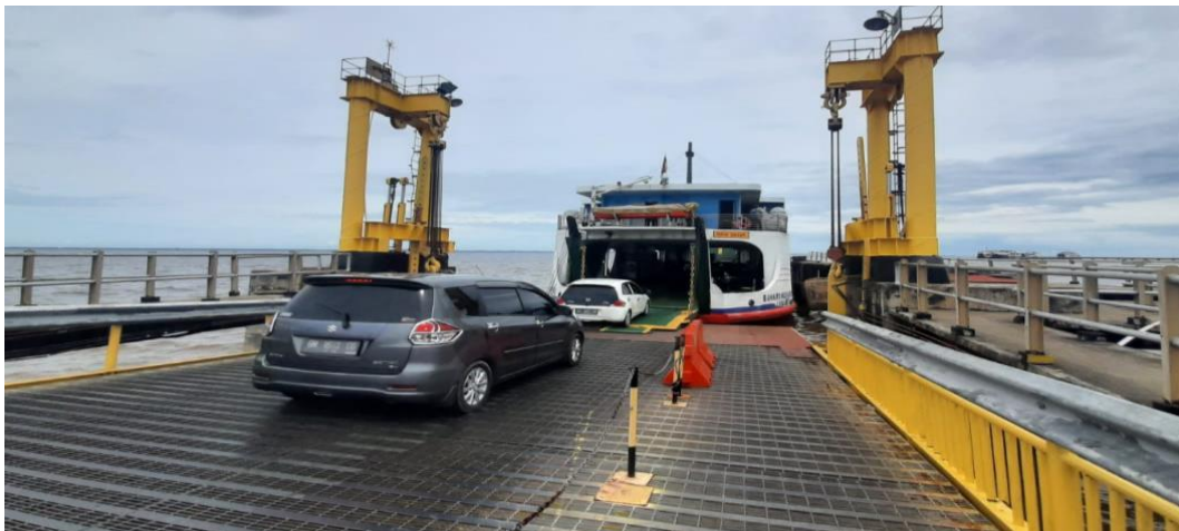
Gambar 4. 11 Dermaga 1 Pelabuhan Penyeberangan Air Putih
