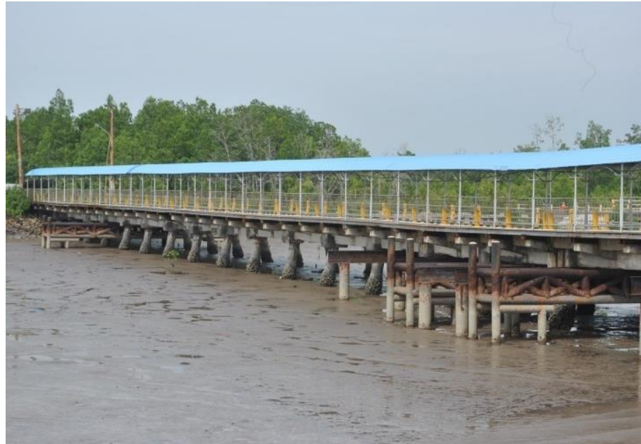
Gambar 4. 10 Trestle pada Dermaga 1 (Satu)
