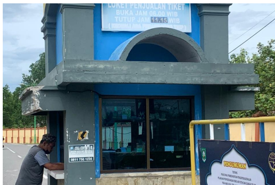
Gambar 4. 17 Loket Pelabuhan Penyeberangan Air Putih
