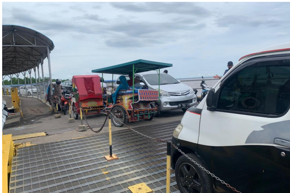
Gambar 5. 1 Kondisi di Movable Bridge
