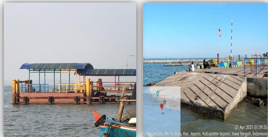
Gambar 4.5 Dermaga Plengsengan dan Dermaga Ponton
