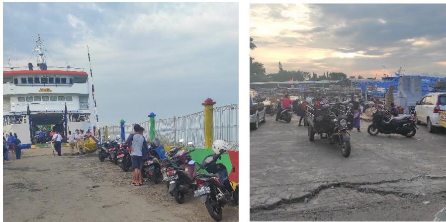
Gambar 5.4 Kondisi di trestle Pelabuhan Penyeberangan Jepara
