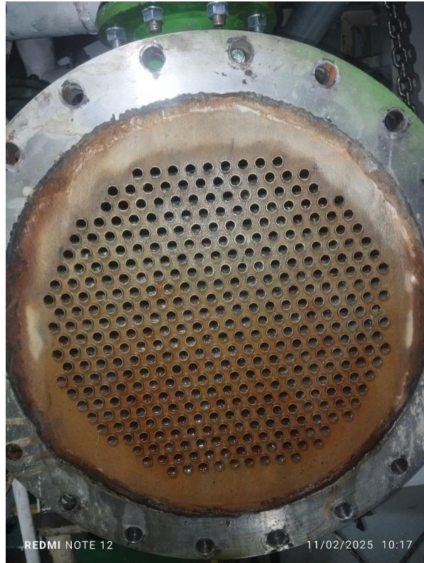
Lampiran 6 cubing cooler setelah dibersihkan
