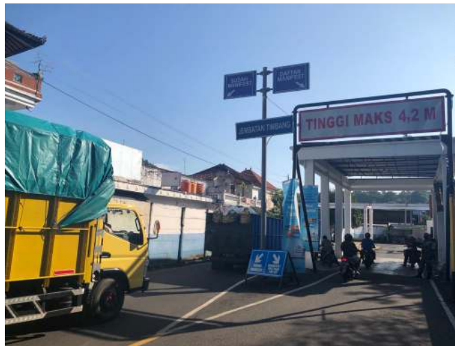
Gambar 5. 1 Jembatan Timbang Yang Tidak Digunakan
