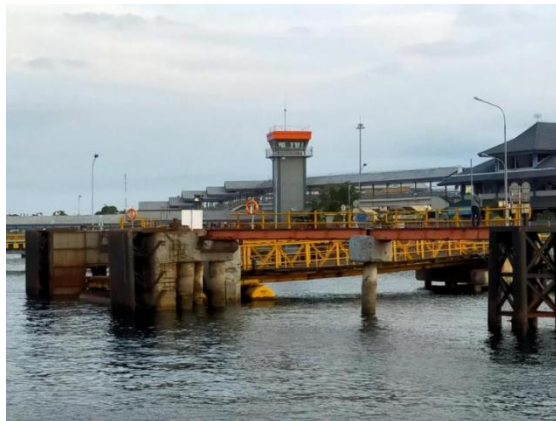
Gambar 4.15 Trestle di Pelabuhan Penyeberangan Ketapang 32
