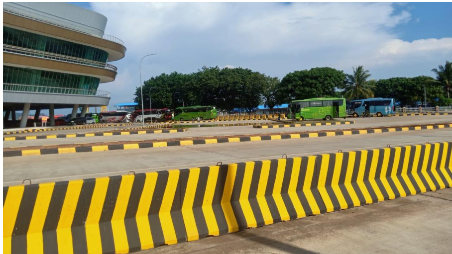
Gambar 5.2 Kondisi Eksisting Lapangan Parkir.
