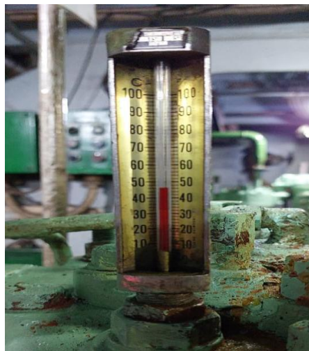
Gambar 4. 2 Pendingin kompresor mengalami overheat
