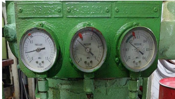
Gambar 4. 3 Pressure gauge kompresor menurun
