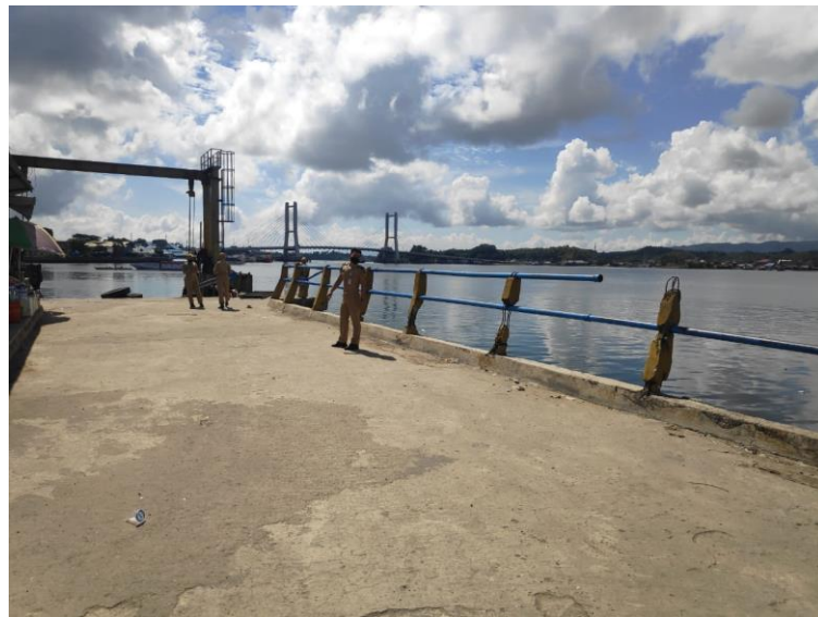
Gambar 4.8 Trestle Pelabuhan Kendari
