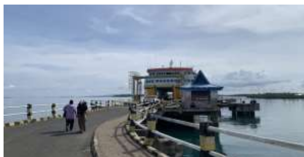
Gambar 4.8 Trestle Pelabuhan Arar
