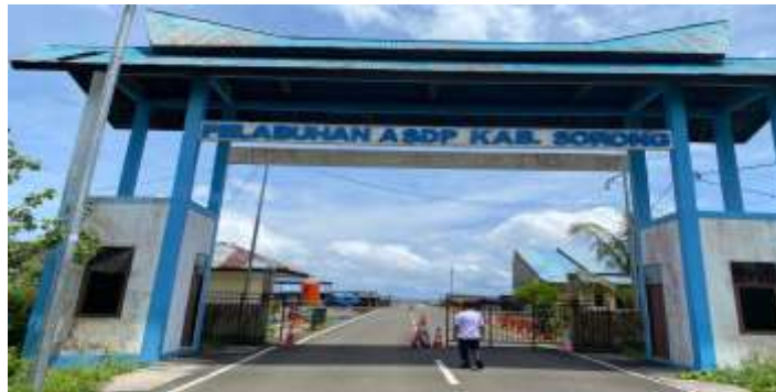
Gambar 4.15 Tidak Tersedianya Jembatan Timbang Kendaraan
