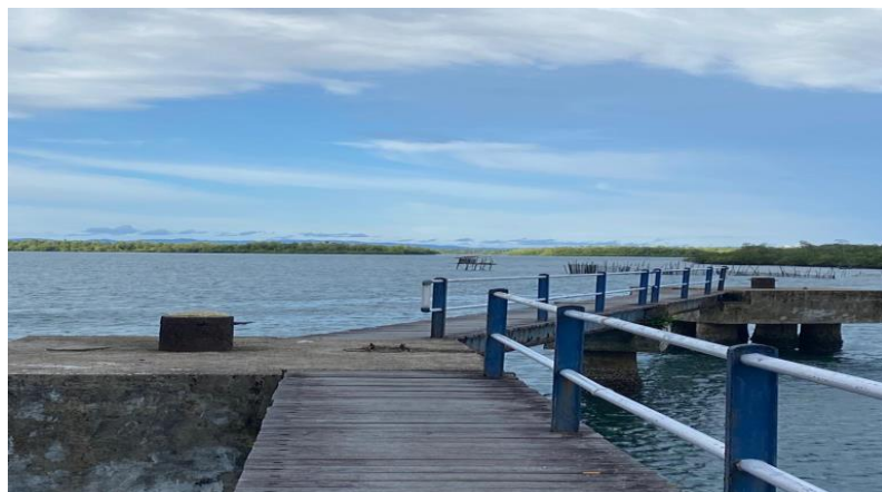
Gambar 4.14. Catwalk Pelabuhan Arar
