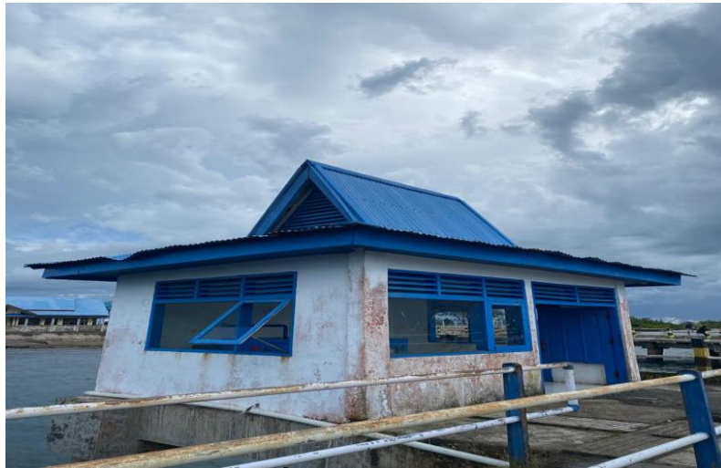
Gambar 4.11. Rumah Movable Bridge Pelabuhan Arar
