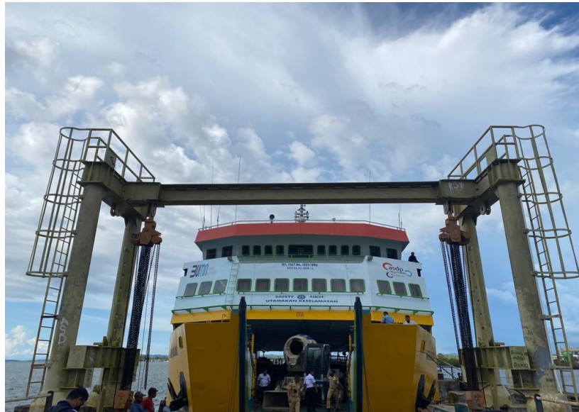
Gambar 4.9. Movable Bridge Pelabuhan Penyeberangan Arar Sumber : Laporan PKL BPTD Wilayah XXV Provinsi Papua & Papua Barat 2022
