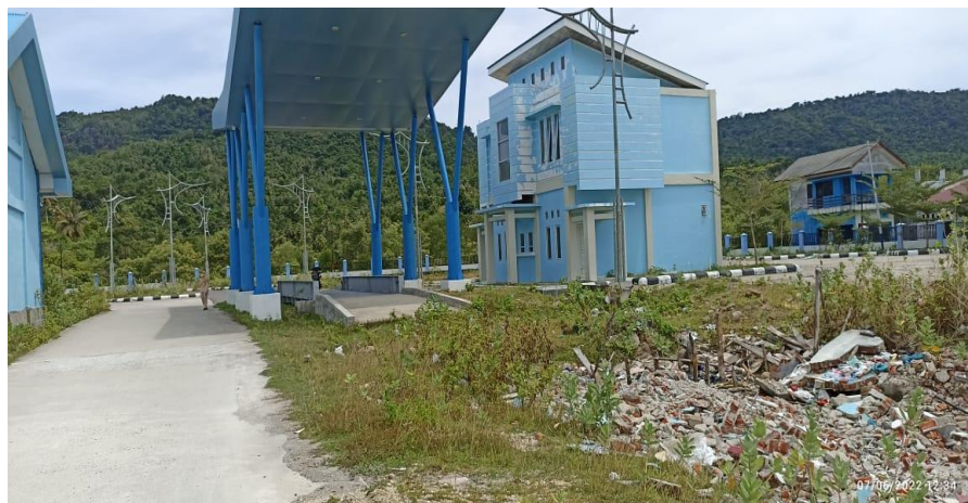
Gambar 4.26 Kondisi eksisting jembatan timbang
