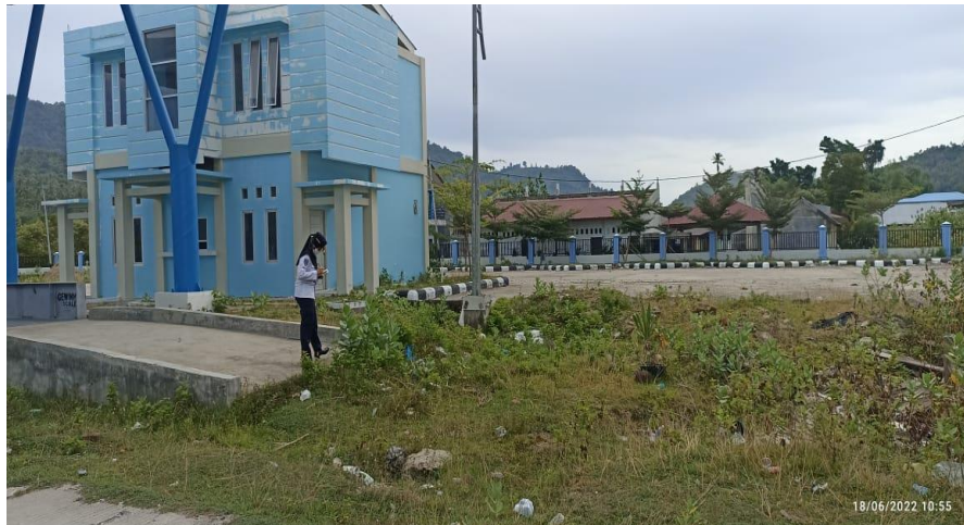
Gambar 4.25 Kondisi Eksisting Jembatan Timbang\
