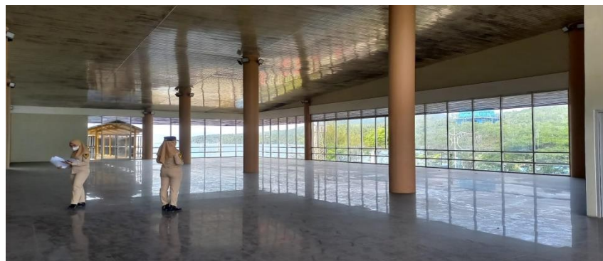
Gambar 4.23 Kondisi Ruang Tunggu Lantai 2
