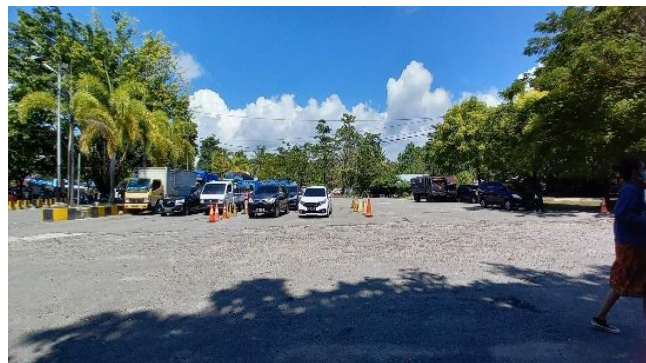
Gambar 4.8. Kondisi Lapangan Parkir
