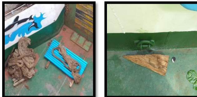
Gambar 4.36. Kondisi Alat Lashing dan Klem Yang Disediakan
