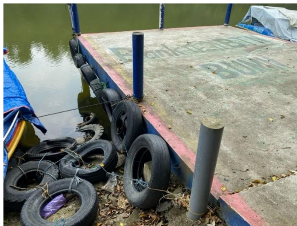
Gambar 4. 29 Fender di Waduk Jatibarang Sumber: Tim PKL BPTD Kelas I Jawa Tengah (2025)
