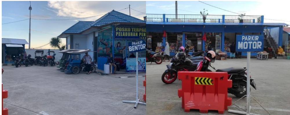
Gambar 4. 10 Lapangan parkir roda 2 dan roda 3 pengantar / penjemput di Pelabuhan Penyeberangan Gorontalo
