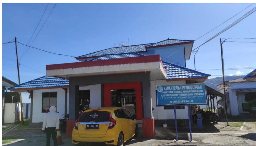
Gambar 4. 9 Ruang kantor di Pelabuhan Penyeberangan Gorontalo
