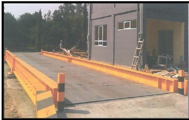
Gambar 4. 25 Jembatan Timbang Tipe Permanen
