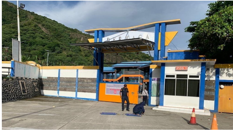
Gambar 4. 6. Causeway di Pelabuhan Penyeberangan Gorontalo
