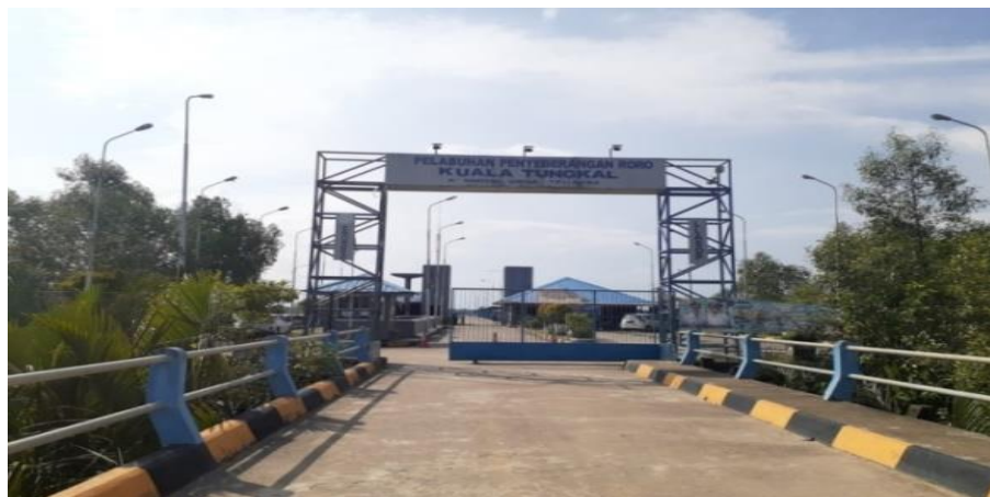
Gambar 1. 1 Pelabuhan Penyeberangan Kuala Tungkal
