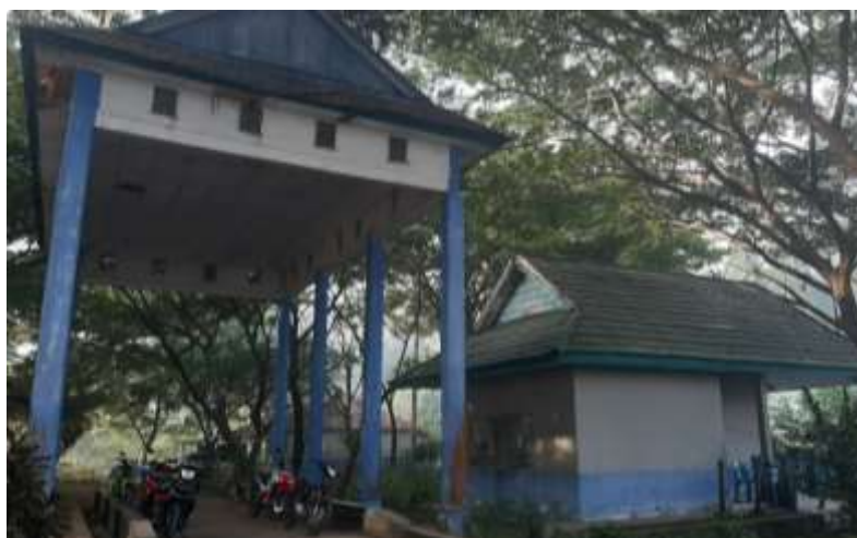
Gambar 4. 41 Jembatan Timbang yang Tidak Digunakan
