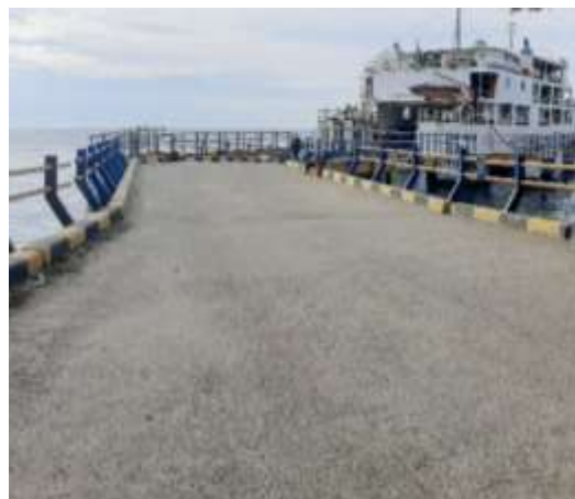
Gambar 4. 22 Trestle di Dermaga Plengsengan
