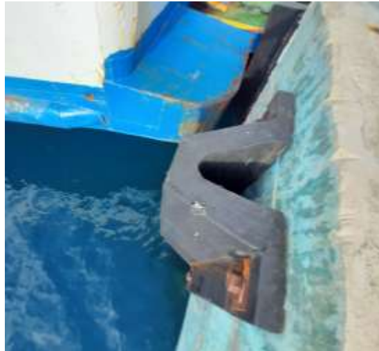
Gambar 4. 19 Fender di Pelabuhan Tobaku
