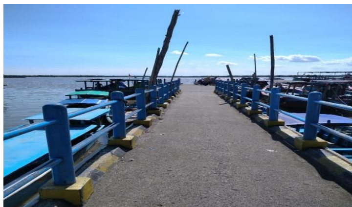
Gambar 4.10 Trestle Dermaga Seleko
