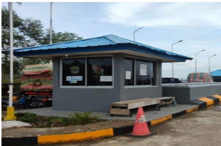
Gambar 4.15 Gedung Loket Kendaraan Sumber : Dokumentasi Tim PKL Jambi (2022)
