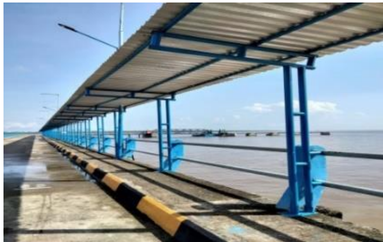
Gambar 4.8 Gangway Sumber : Dokumentasi Tim PKL Jambi (2022)
