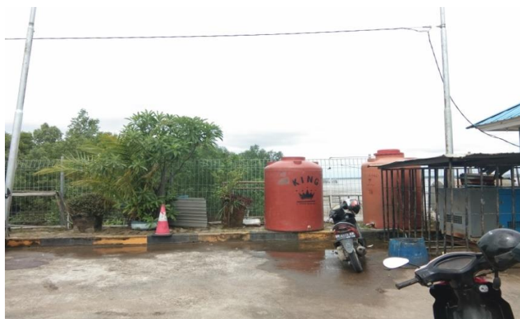
Gambar 4.18 Instalasi Air Sumber :Dokumentasi Tim PKL Jambi (2022)
