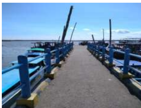
Gambar 4.10 Trestle Dermaga Seleko Sumber : Tim Pkl Jateng&Diy 2022
