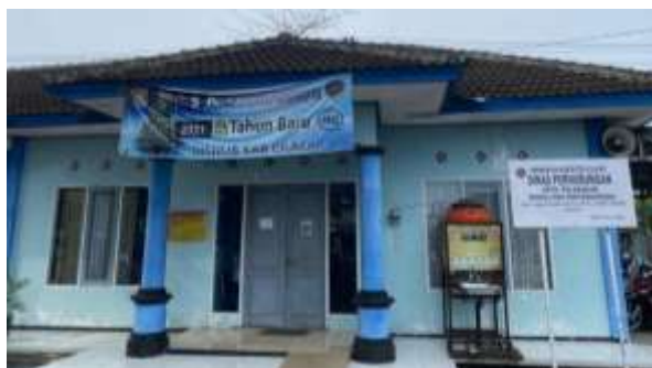
Gambar 4.7 Kantor Pelabuhan Seleko Sumber : Tim Pkl Jateng&Diy 2022
