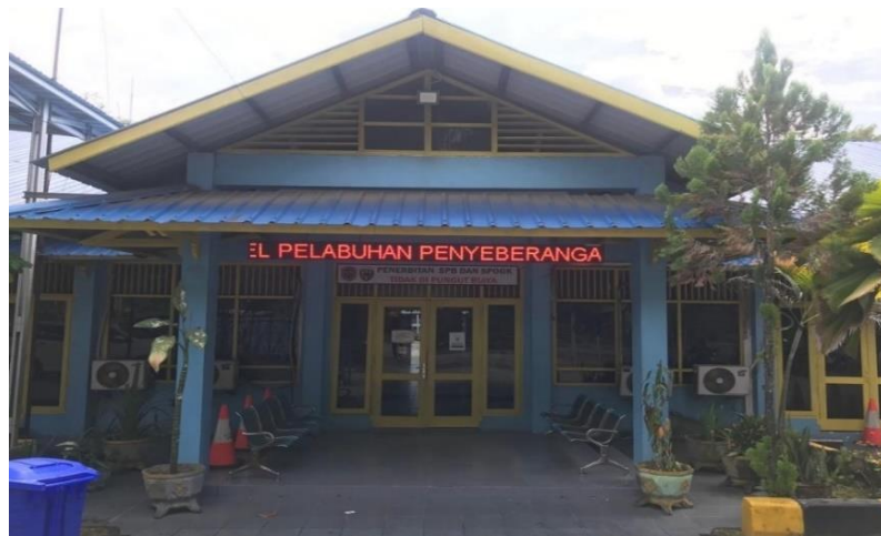
Gambar 4.3 Kantor Pelayanan di Pelabuhan Kariangau
