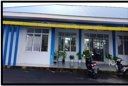
Gambar 4.10. Kantor Pelabuhan Penyeberangan Likupang
