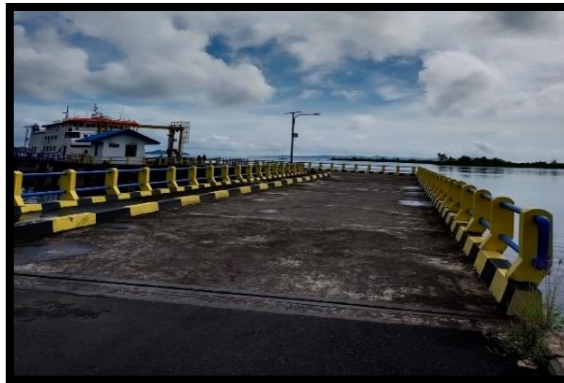
Gambar 4.7 Trestle Pelabuhan Penyeberangan Likupang Sumber: Dokumentasi TIM PKL SULUT, 2022
