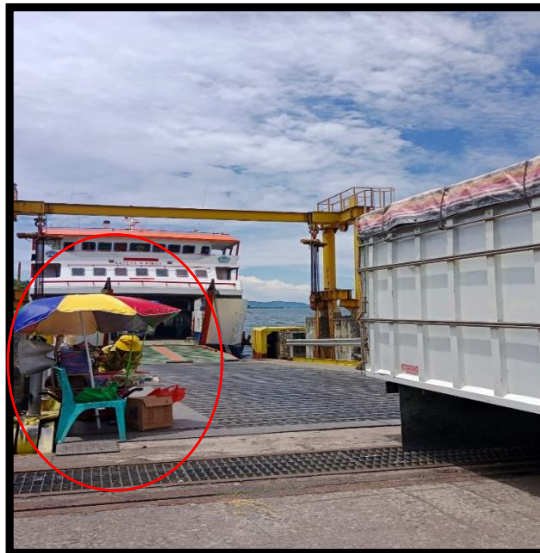
Gambar 4.22. Kondisi Orang berjualan di Movable Bridge Sumber: Dokumentasi TIM PKL SULUT, 2022
