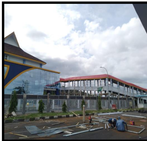
Gambar 4.8. Gedung Terminal Pelabuhan Penyeberangan Likupang Sumber: hasil dokumentasi, 2022
