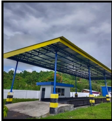
Gambar 4.29. Kondisi Jembatan Timbang Pelabuhan Penyeberangan Likupang Sumber: Dokumentasi TIM PKL SULUT, 2022
