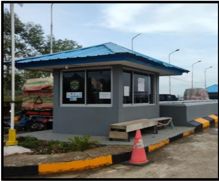
Gambar 4.16 Gedung Loker Kendaraan Sumber : Laporan PKL BPTD Jambi (2022)
