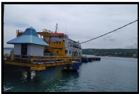
Gambar 4.26Ruang Kontrol MB I
