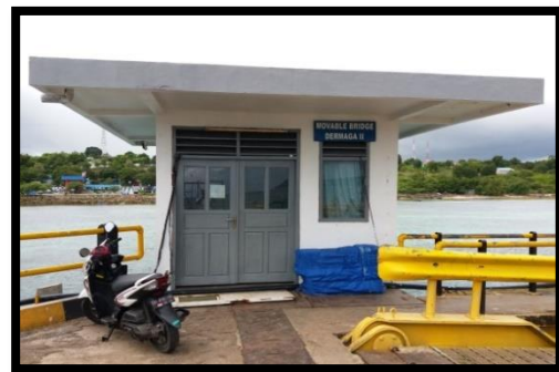
Gambar 4.27Ruang Kontrol MB II
