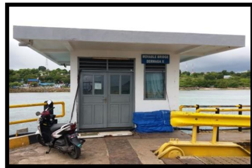
Gambar 4.27Ruang Kontrol MB II
