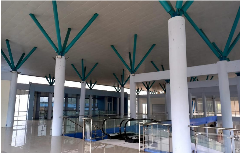
Gambar 4.16 Kondisi lantai atas gedung terminal
