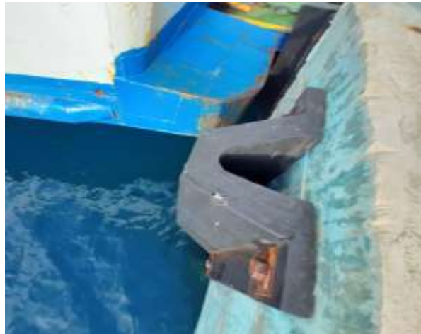
Gambar 4. 22 Fender di Pelabuhan Tobaku
