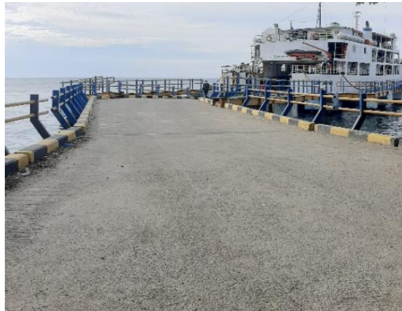
Gambar 4. 25 Catwalk di Dermaga Pelengengan
