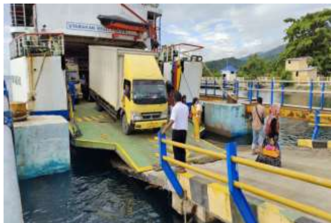
Gambar 1. 2 Kondisi Pintu Rampa KMP. Merak
