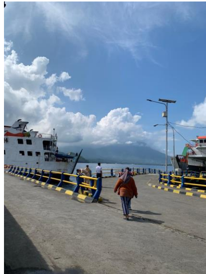
Gambar 4. 15 Trestle Sumber: Dokumentasi Tim PKL BPTD Maluku Utara,2022
