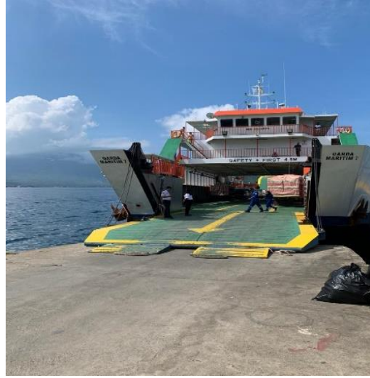
Gambar 4. 14 Dermaga Tipe Pelengsengan Sumber: Dokumentasi Tim PKL BPTD Maluku Utara,2022
