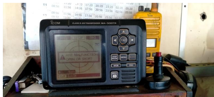
Gambar 4. 29 Kondisi peralatan AIS yang rusak
