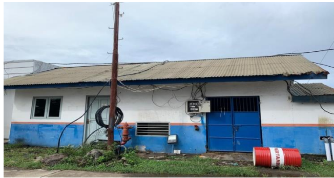
Gambar 4. 8 Ruang Generator Sumber: Dokumentasi Tim PKL BPTD Maluku Utara,2022
