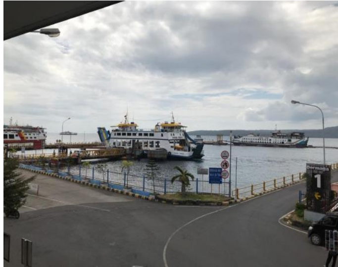
Gambar 4.20 Kolam Pelabuhan Pelabuhan Penyeberangan Ketapang
