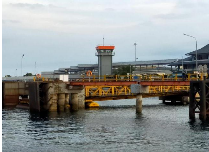
Gambar 4.15 Trestle Pelabuhan Penyeberangan Ketapang
