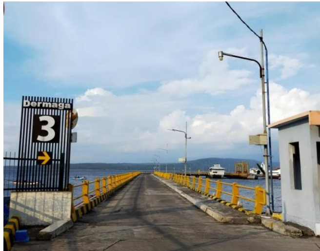
Gambar 4.17 Movable Bridge Pelabuhan Penyeberangan Ketapang
