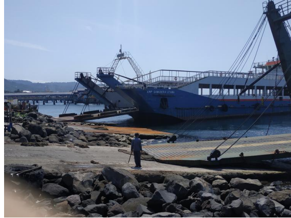
Gambar 4.18 Dermaga Plengsengan Pelabuhan Penyeberangan Ketapang
