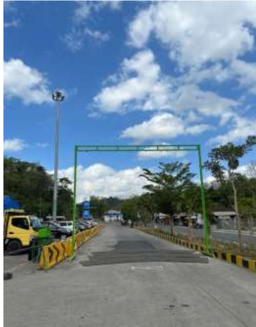
Gambar 4.27 Kondisi Di Depan Tollgate
